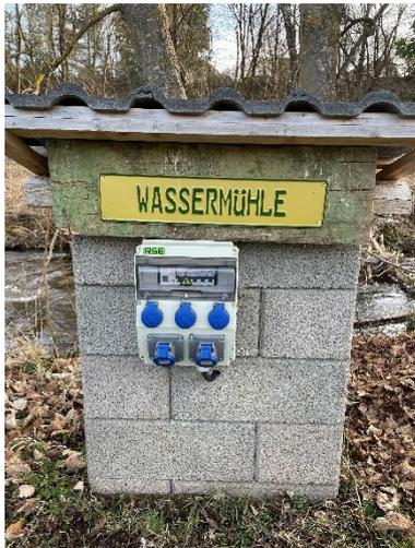
Der Stromanschluss befindet sich genau in der Mitte der drei Stellplätze. Es gibt drei Schuko-Anschlüsse und zwei CEE-Anschlüsse.
